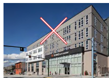
Fig. 4-24. Unacceptable cornice examples.
